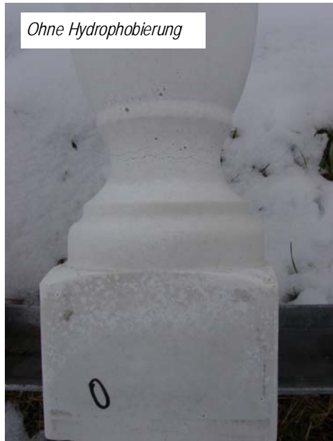
ungleichmäßiger, fleckiger Farbeindruck, Schwindrisse im Bereich der Einschnürung, Alter ca. 2 Monate
